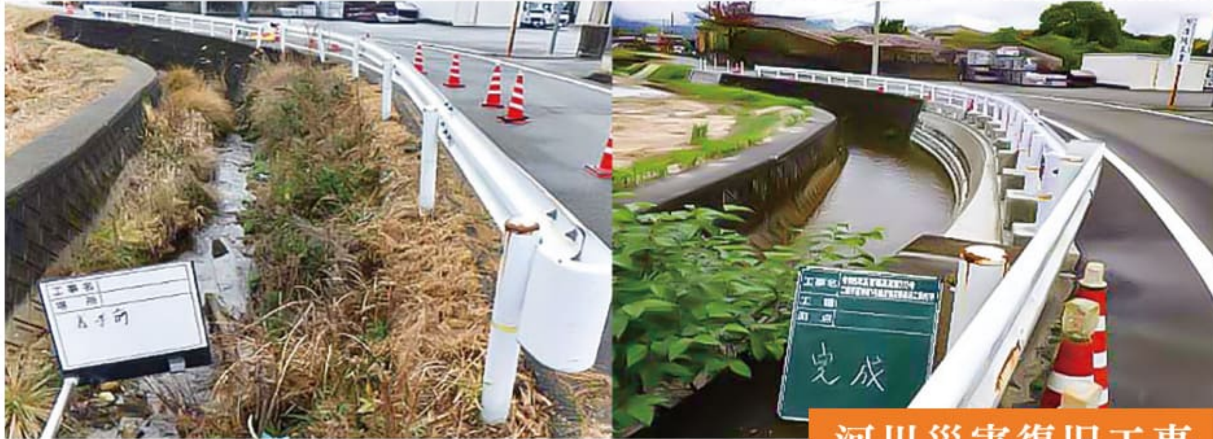
河川災害復旧工事
