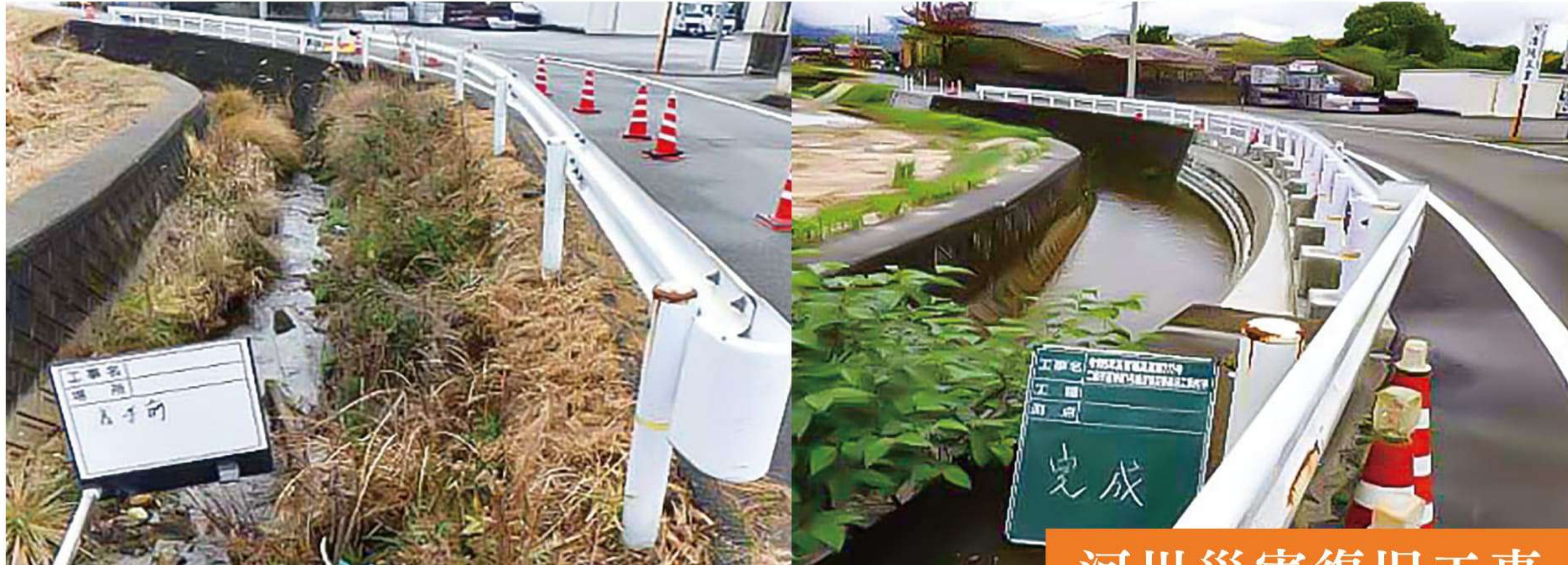
河川災害復旧工事
